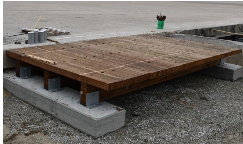
(d) Layout of Glulam Panels on Deck
