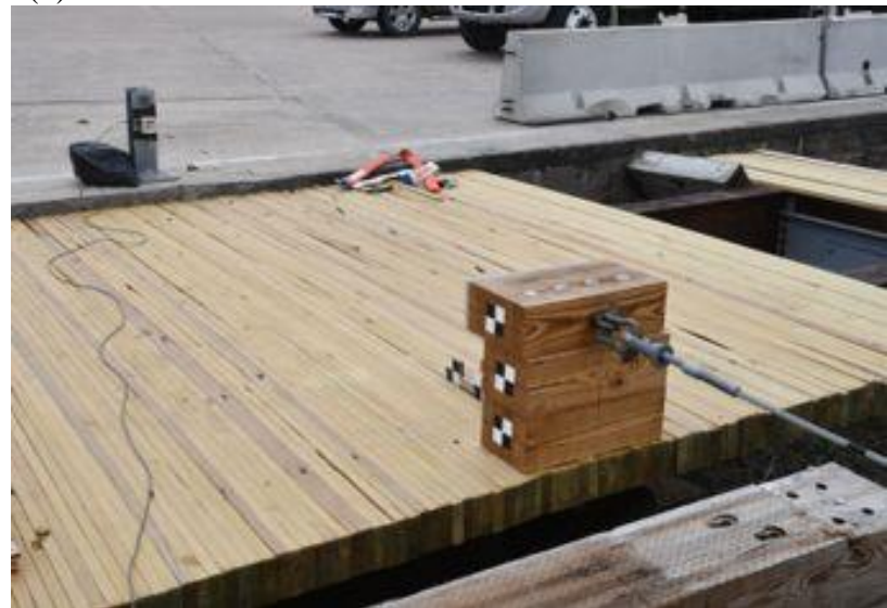
(d) Back View of Nail-Laminated Deck
