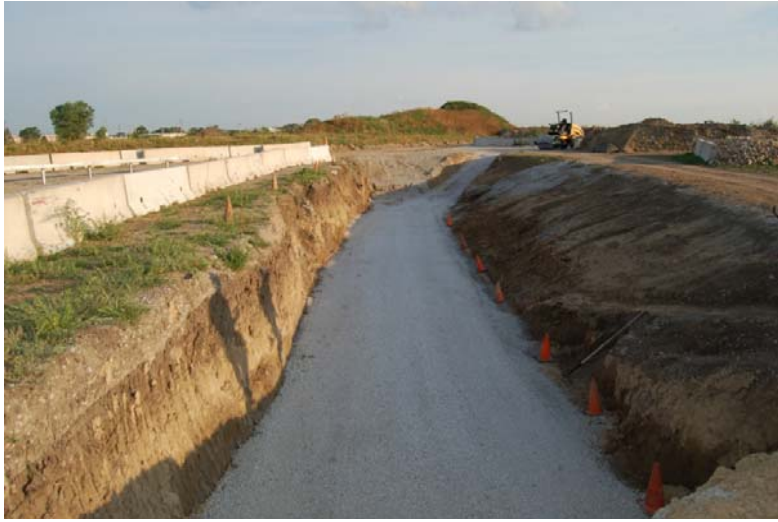
a. MSE Wall, Pit Base Layer
