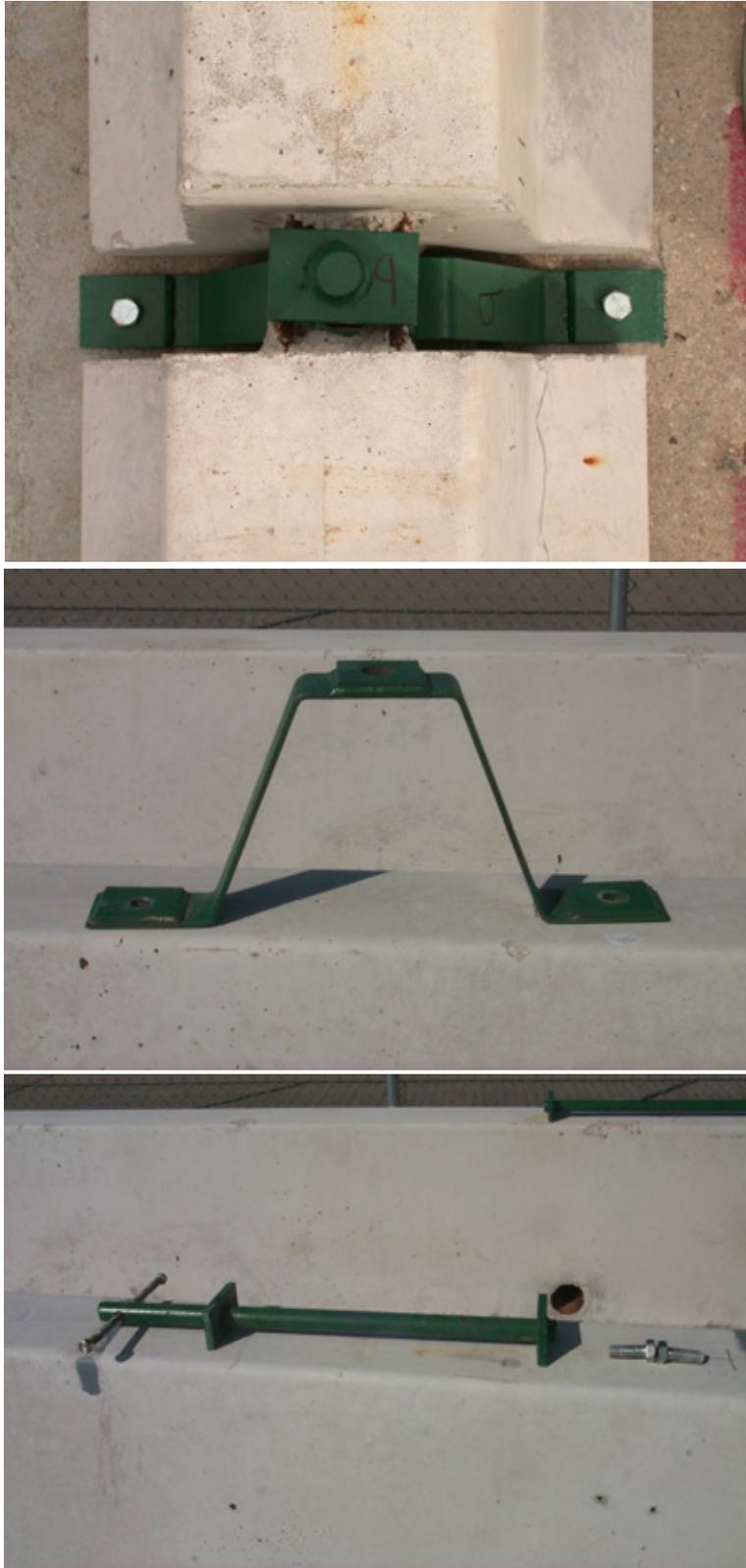
Figure 28. Tie-Down Temporary Barrier System
