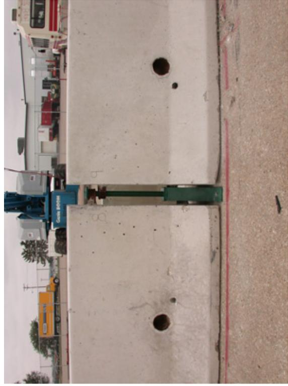
Figure 27. Tie-Down Temporary Barrier System
