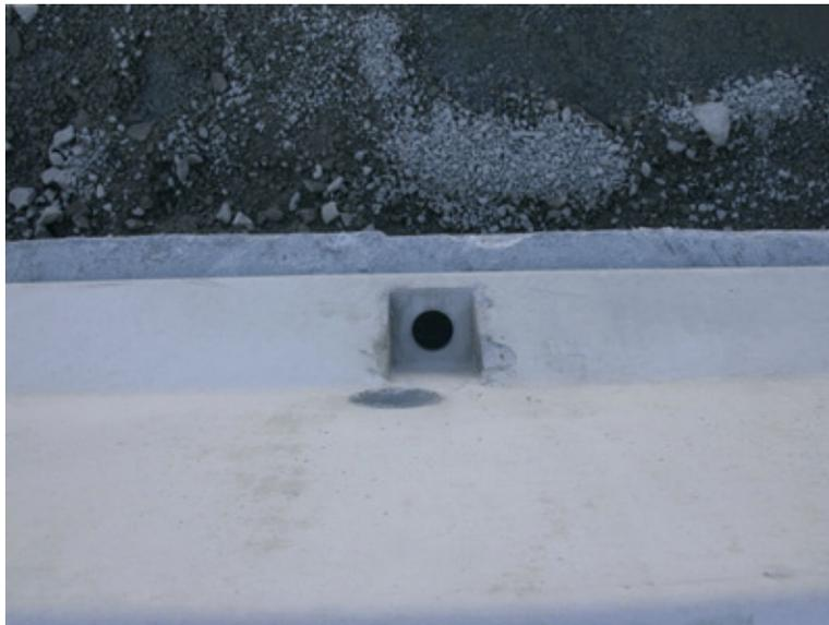
Figure 10. Barrier Tie-Down System
