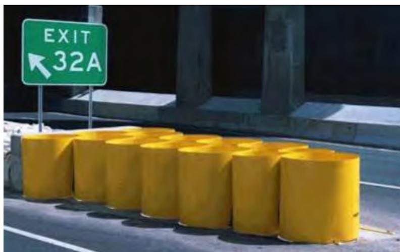
**Figure 29. Connecticut Impact Attenuator System.**
