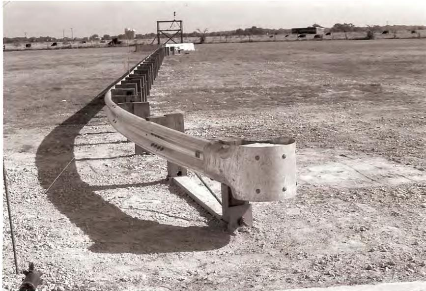
**Figure 28. Modified Eccentric Loader Terminal.**
