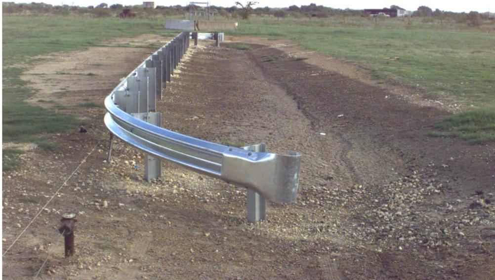
**Figure 27. Vermont Low-Speed Guardrail Terminal.**
